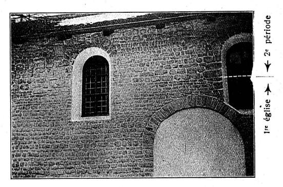
Fig. 26. Une caractéristique du pelit appareil en face sud. La porte murée est la porte de l'église primitive.
