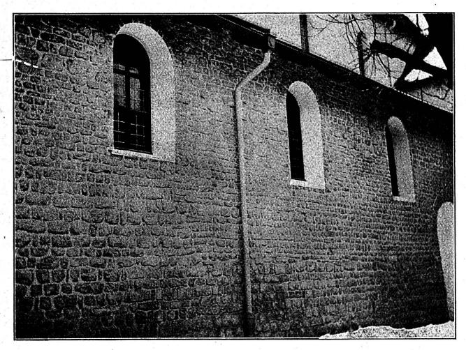
Fig. 25. La différence d'appareil visible à mi-hauteur des fenêtres, bas-côté sud.
