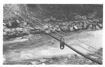
Fig. 6 Tirage d'un câble à travers la Reuss près d'Amsteg
