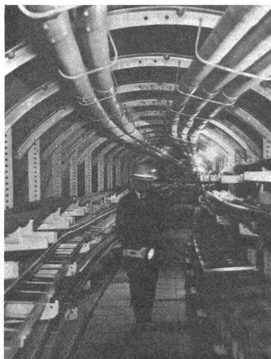
Fig. 26 La galerie de câble de 1,3 km de longueur située dans le réseau de Yaesu
