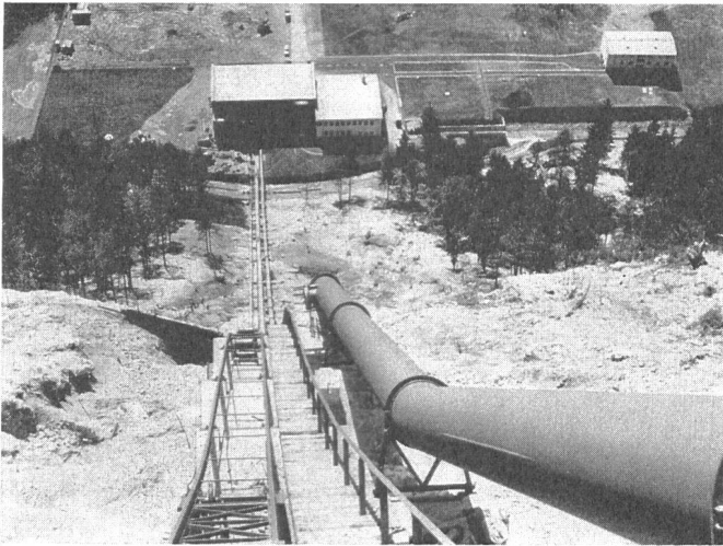
Fig. 7 Das Diessbachwerk mit vorerst einer Druckrohrleitung
