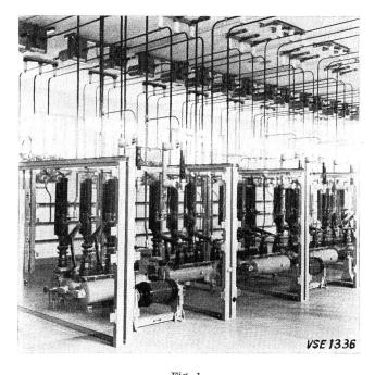
Installation à 16 kV d'une sous-station télécommandée, disposition de type ouvert
