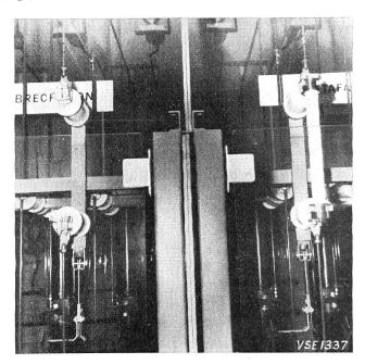
Fig. 5 Panneaux de protection insérés entre deux travées à 16 kV d'une sous-station du type ouvert
