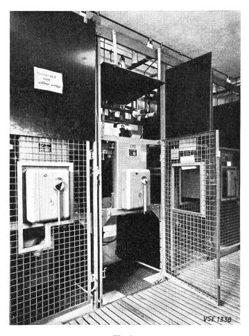
Fig. 6 Travée à 19 kV préparée pour les travaux; le panneau de protection de droite n'est pas complètement en place
