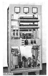
Fig 11 montre le bâti de commutation des batteries avec les contacteurs  $S\,1/S\,2$  vus précédemment et la valve assurant la commutation sans interruption, ainsi que les lampes de signalisation.
