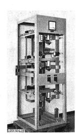
Fig. 11 Commutation automatique des batteries à 22/25 éléments
