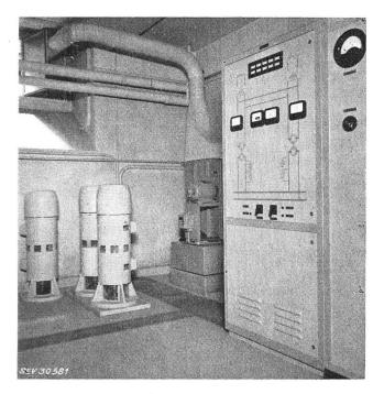
Fig. 13 Energieversorgungsanlage 10 kVA, 220 V, 50 Hz, für Koaxialkabelverstärker
