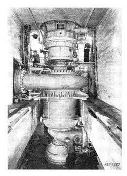
Fig. 1 Transformateur de couple de la centrale du Lünersee
