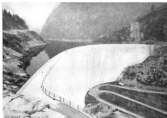
Fig. 3 Ausgleichbecken Malvaglia Betriebsbereit seit 1959 Nutzinhalt 4 Millionen m 3 ; Höhe der Bogenstaumauer 92 m; Betonkubatur 164 000 m 3
