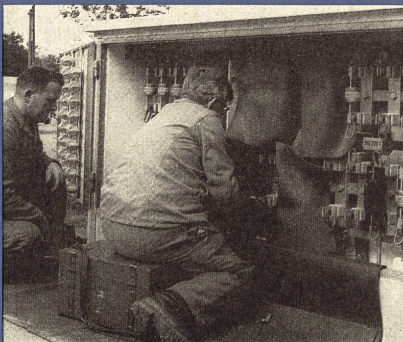
❹ Dépannage d'un coffret de distribution
