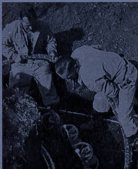
⑤ Remplacement d'un câble à basse tension
