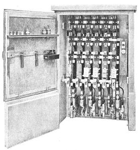
Fig. 1 Eintürige Kabelverteilkabine ganz geöffnet
