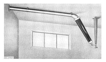
Isolierte Sammelschiene mit Endisolator und Giessharz-Stützer für eine Spannung von 150 kV und einen Nennstrom von 800 A
