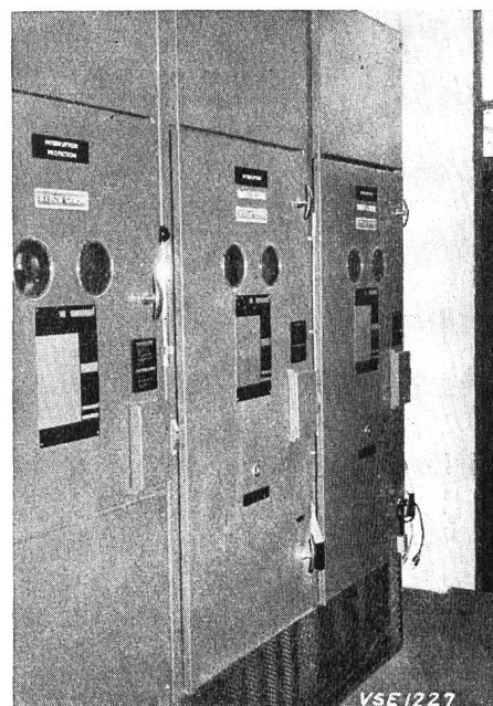
Fig. 7 Vue de face d'une armoire de couplage
