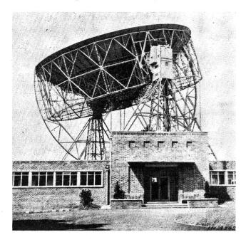
Fig. 1 Radio-Teleskop der Universität Manchester in Jodrell Bank Totalgewicht 1800 t, Spiegeldurchmesser 75 m, Gewicht der Spiegelschale 675 t, totale Höhe bei vollständig gekipptem Spiegel 90 m
