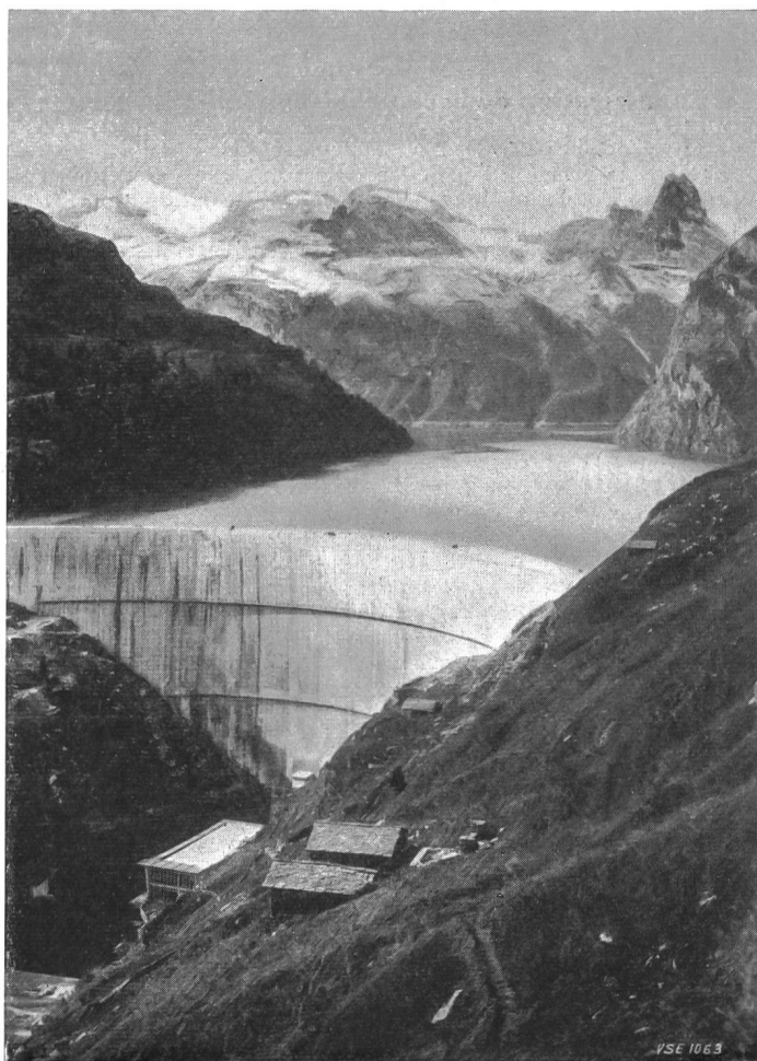
Fig. 2 Le barrage-voûte (hauteur 150 m)
