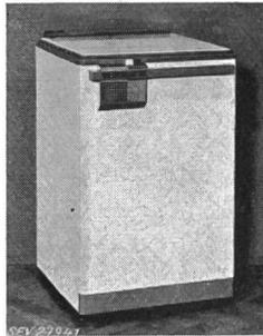
Cette machine à laver la vaisselle a subi avec succès les essais relatifs à la sécurité. Elle est conforme au «Règlement pour l'octroi du signe distinctif antiparasite» (Publ. n° 117 f). Utilisation: dans des locaux secs.
