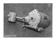
Cet appareil de tintement a subi avec succès les essais relatifs à la sécurité. Utilisation: à des endroits secs ou temporairement humides, pour 500 V au maximum.
