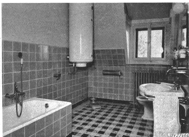
Fig. 3 Baignoire, lavabo et bidet qui ne purent être dégelés malgré l'insistance des monteurs
