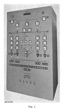
Steuerschrank eines ferngesteuerten Gasturbinenkraftwerkes mit 100 MW Leistung
