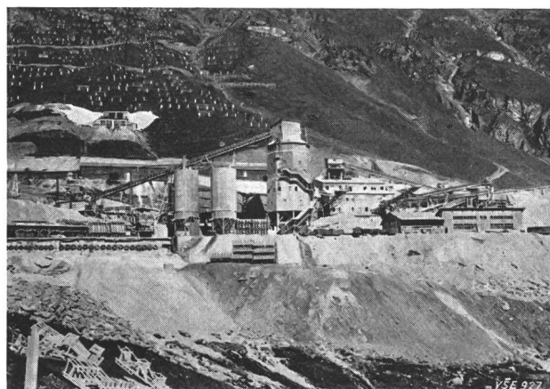
Fig. 3 Protection de baraquements ouvriers contre le danger d'avalanches
