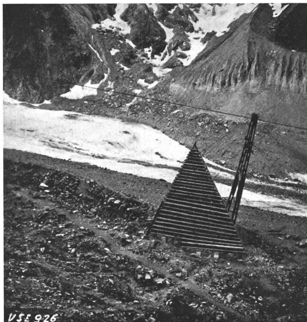
Fig. 2 Protection d'un pylône de téléphérique contre le danger d'avalanches
