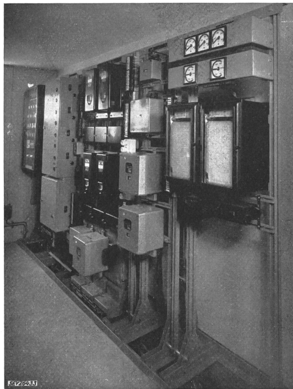
Fig. 9 Relaisstation der Freiluftanlage «Kaisterfeld»
