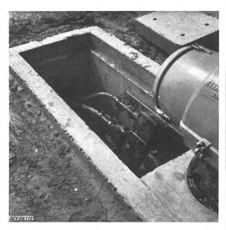
Fig. 12 Lampenschacht mit Abzweigkasten aus Gusseisen und mit Kabelendverschlüssen auf Eisenrahmen montiert
