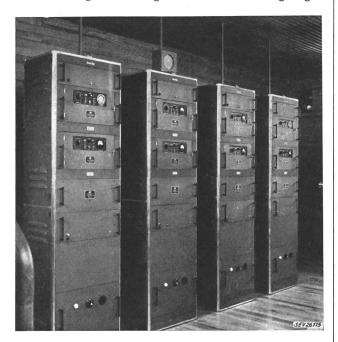
Fig. 15 Kurzwellenempfänger für die drahtlose Sprechverbindung Boden—Luft
