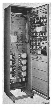
Fig. 10 Recheneinheit des Pile-Simulators mit geöffneter Türe
