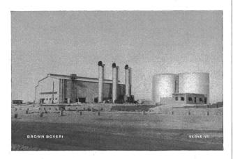
Fig. 3 Gasturbinenkraftwerk Jeddah am Roten Meer mit drei einwelligen 6000-kW-Gasturbinengruppen
