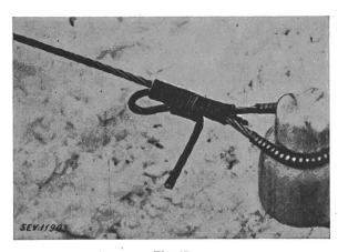
Fig. 17 Attache terminale ou d'arrêt prévue pour dérivation. Noter la boucle allongée que forme le conducteur
