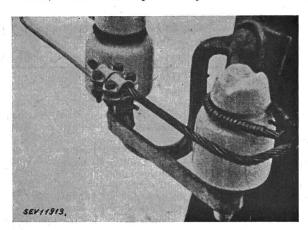
Fig. 29 Jonction de conducteurs unifilaires en cuivre et en alliage Ad, Serre-fils à collier avec garniture en aluminium plaqué de cuivre. Al en dessus, Cu en dessous
