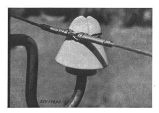
Fig. 12 Attache croisée avec deux fils de ligature
