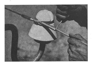
Fig. 9 Attache croisée renforcée Terminaison d'une des spirales de la ligature. Cette attache a été confectionnée sans l'aide d'un outil!
