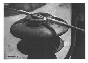
Fig. 15 Attache supérieure terminée, sur isolateur prévu spécialement dans ce but
