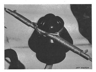
Fig. 14 Attache à collier constituée par un tronçon de corde
