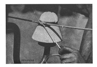
Fig. 8 Confection d'une attache croisée renforcée Les deux brins du fil de ligature ont déjà entouré une fois la gorge de l'isolateur. A l'endroit du croisement, les deux brins doivent demeurer parallèles!
