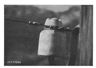
Fig. 6 Attache croisée simple (pour conducteurs unifilaires minces) sans ruban
