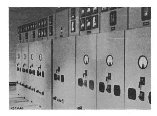
Fig. 6 Blocs de couplage dont la partie amovible s'enlève horizontalement
