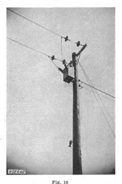
Poste de transformation «de ferme» monophasé avec coupe-circuit à fusibles du côté à basse tension
