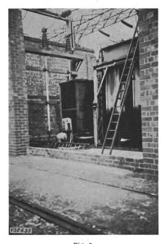
rig. 3 Transformateur protégé de trois côtés par un muret et alimenté par câbles souterrains isolés à l'asbeste, dans une sous-station
