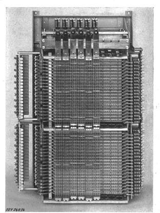
Fig. 7 Kreuzwähler mit 40 Quer- und 6 Längsgliedern
