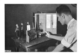
Fig. 3 Appareil pour déterminer l'indice d'acidité des huiles
