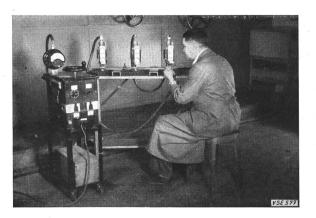
Fig. 2 Contrôle des relais thermiques Transformateur spécial pour essais de relais
