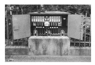
Fig. 13 Coffret de distribution de câbles pour villas Remarquez les lampes de chauffage
