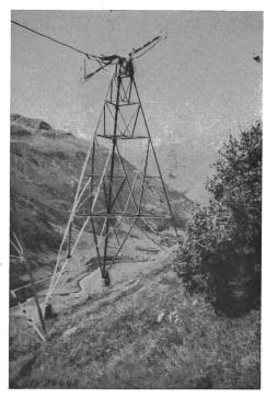
Fig. 5 Pylône de la traversée du Val d'Urseren Portée de 1037 m
