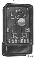
doanlagen entwickelt, u. a. ein Kleinschütz, welches ausser der Sperrzeit jederzeit durch einen Druckknopf eingeschaltet werden kann, sofern die Einschaltung freigegeben ist. Eingeschaltete Schütze können aber durch die Netzkommandoanlage jederzeit ausgeschaltet werden. Mit einer kleinen Netzkommandoanlage werden solche Spezialschütze in Betrieb gezeigt.
