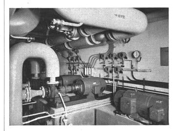
Fig. 1 Ward-Leonard-Umformergruppe und Gleichstrom-Nebenschluss-Motoren für röhrengesteuerte Pumpenantriebe mit automatischer Regelung auf konstanten Druck
