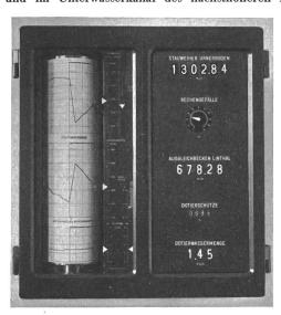
Fig. 2 Registrierempfänger in einem Kraftwerk
