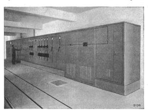
Fig. 2 HS/NS-Innenraum-Blockanlage 8000/380 (220) V, Leistung  $2 \times 800$  VA
