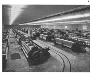
Fig. 4 Sulzer Baumwoll-Webmaschinen in einer modernen französischen Weberei
