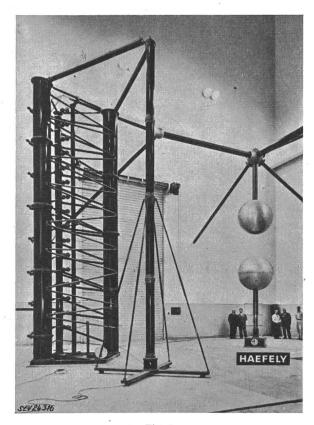
Fig. 2 Stoßspannungsanlage für 2400 kV
