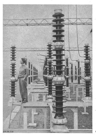
Fig. 1 220-kV-Stützer Freiluftschaltanlage Bodio der Atel
