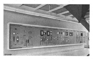
Fig. 7 Kommandoschrank mit Bildschema in eloxiertem Leichtmetall
