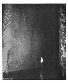
Fig. 1 Turbineneinlauf einer Wasserturbine mit einem 10 m langen Ultraschallgeber (dünne weisse Linie auf der linken Einlaufseite)
