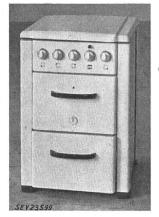
Cuisinière électrique, selon figure, avec quatre foyers de cuisson, un four, un tiroir et un couvercle. Plaques de cuisson de 145, 180 (deux plaques) et 220 mm de diamètre, avec bord en tôle d'acier inoxydable, montées à demeure. Cuvette relevable, mais vissée. Corps de chauffe disposés à l'extérieur du four et réglés ensemble par un thermostat. Bornes prévues pour différents couplages. Poignées isolées.
