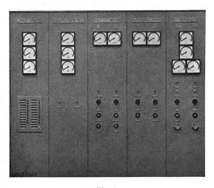
Fig. 6 Moderne Schalttafel mit quadratischen Instrumenten mit 250° Zeigerausschlag
