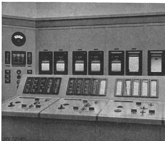
Fig. 3 Schaltpult und Schalttafel mit Profil- und Registrierinstrumenten
