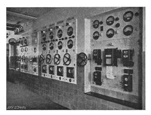
Fig. 2 Alte Schalttafel mit versenkt eingebauten runden Instrumenten
