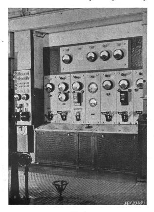
Fig. 1 Alte Marmor-Schalttafel mit aufgebauten runden Instrumenten
