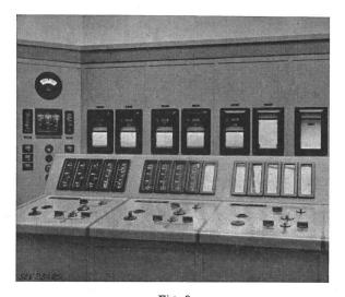
Fig. 3 Schaltpult und Schalttafel mit Profil- und Registrierinstrumenten
