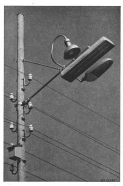
Fig. 1 Versuchsstrecke Hegnau-Dübendorf Leuchten für drei verschiedene Lichtquellen
