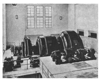
Fig. 9 Groupe convertisseur de fréquence 50 Hz/16% Hz, 10 625 kVA
