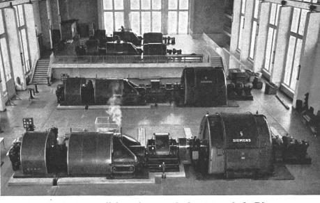
l'électrification de la région de la Rhur, on a tout d'abord mis en service un groupe turbo-alternateur monophasé dans une centrale d'une entreprise livrant de l'énergie à des tiers; de plus, on installe actuellement des groupes convertisseurs asynchrone/ synchrone. La fig. 12 représente un groupe convertisseur utilisé pour un tel mode d'alimentation du
