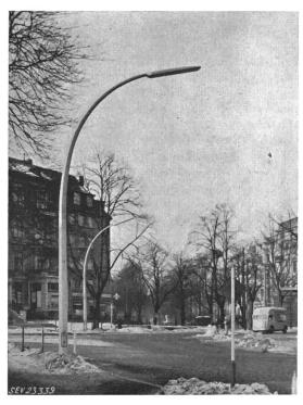
Fig. 6 Peitschenmast für Fluoreszenzlampen
