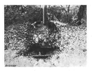
Fig. 14 Blitztrichter an Wasserleitung vor dem Messraum
