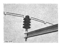
Fig. 7 Le nouvel isolateur rigide de la fig. 6 pour 20 kV La figure montre la fixation du câble conducteur par l'intermédiaire d'un câble auxiliaire
