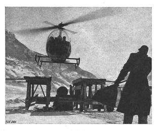
Fig. 2 Podium installé à la base de départ à Ambri permettant de fixer la charge à l'héliocoptère. On distingue sur la rampe de chargement un tonneau d'huile de 200 kg prêt pour le transport en direction du Gothard
