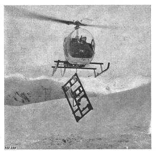
Fig. 5 L'hélicoptère arrive à l'hospice du Gothard avec un support de transformateur pesant 230 kg
