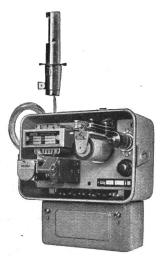
Auf besonderes Interesse dürfte die neue elektro-Heizungsregelung nische «Equitherm» stossen, die schon in ihrer frühern Ausführung weiteste Verbreitung gefunden hatte. Der Aussenfühler ist bedeutend kleiner und gefälliger geworden und lässt sich nun unauffällig an der Hausfront montieren. Der Schaltkasten ist mit einem Handschalter zur wahlweisen Einstellung verschiedener
