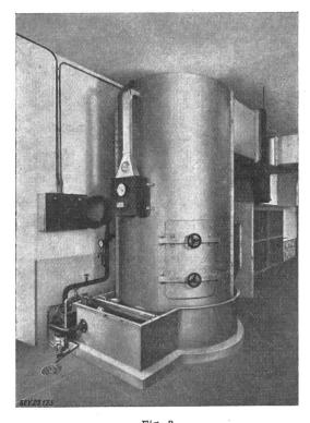
Fig. 3 Sulzer-Klimatiseur für Kühlung, Befeuchtung und Entstaubung der Luft
