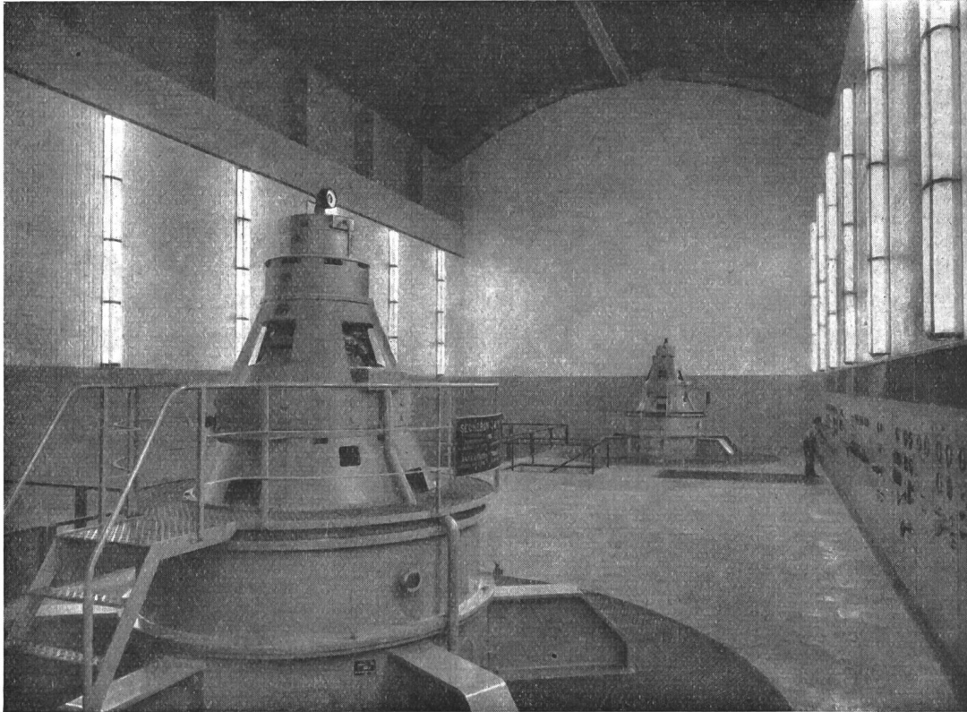
Centrale de Caniçada au Portugal, pour laquelle Sécheron a livré 2 alternateurs de 30 000 kVA, 300 t/min, 2 transformateurs 10/158 kV et 2 régulateurs de tension REX-Sécheron
