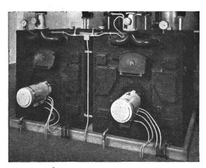
Fig. 1 Heizkessel mit 2 ölbrennern
