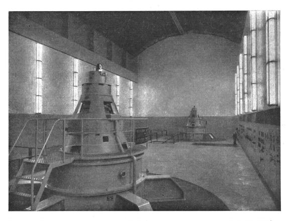
Centrale de Caniçada au Portugal, pour laquelle Sécheron a livré 2 alternateurs de 30 000 kVA, 300 t/min, 2 transformateurs 10/158 kV et 2 régulateurs de tension REX-Sécheron
