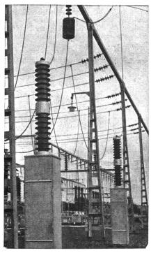
Fig. 2 Kopplungskondensatoren
