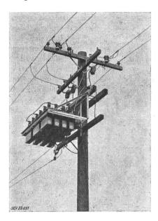
Fig. 1 300-kVar-Kondensatorenbatterie auf einem Leitungsmast einer 2,4/4,16-kV-Leitung (Näheres siehe in Abschnitt 5)
