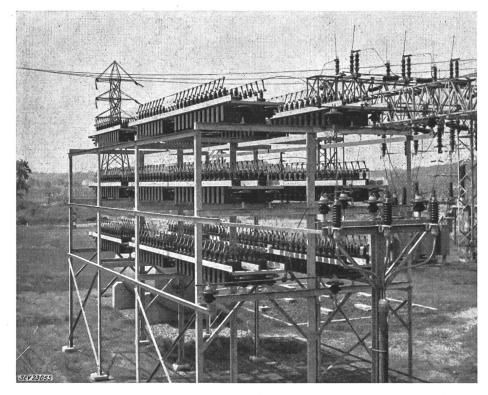
Bei grösseren Anlagen von einigen Tausend kVar werden die Kondensatoren fast immer individuell abgesichert. Das genügt jedoch nicht, vielmehr muss noch ein Relaissystem eingeordnet werden, welches schadhafte Spannungsungleichheiten innerhalb der Batterie aufdeckt. Bei dauernder Überspannung von mehr als 10 % an irgend einer Seriegruppe muss das
