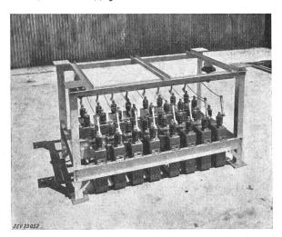
Fig. 2 400-kVar-Block-Einheit mit 16 Kondensatoren (Näheres siehe in Abschnitt 5)
