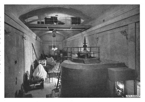
res dans des cellules séparées, complètement closes, avec écoulements d'huile indépendants; puis des mesures de défense active par protections à gaz carbonique, munies de commandes automatiques pour les trois alternateurs et les cinq transformateurs précités, ainsi que pour la halle de décuvage, mesures complétées par un réseau d'hydrants, avec lances à brouillard, et par des extincteurs portatifs.
