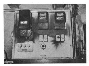
Fig. 3 Tableau principal de distribution dans le châlet Les trois compteurs et un coupe-circuit 15 A, 250 V, inséré dans une conduite d'éclairage ont été détériorés
