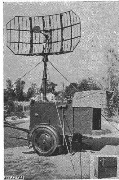
Fig. 22 IFF, Freund-Feind-Erkennungsgerät Reichweite ca. 60 km (Schweiz)
