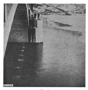
Fig. 2 Aufsteigende Luftblasen verhüten Oberflächeneis entlang der Grand Coulee Staumauer
