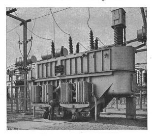
Fig. 17 Transformateur à refroidissement artificiel à circulation forcée d'huile
