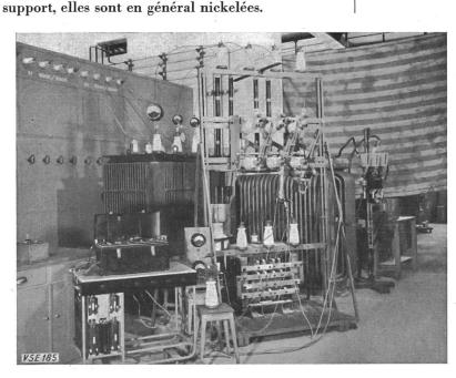
Fig. 13 Essai d'un sectionneur de charge dans une entreprise d'électricité
