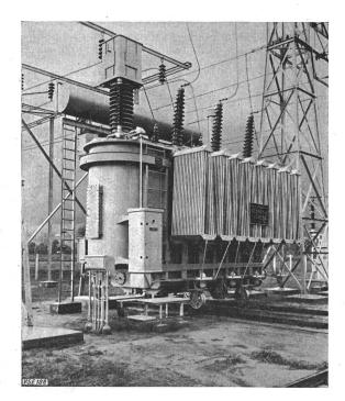
Fig. 16 Transformateur à refroidissement naturel-soufflé
