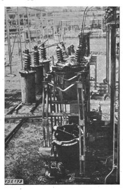
Fig. 2 Explosion d'un disjoncteur dans l'huile à 50 kV par suite de manque de pouvoir de coupure
