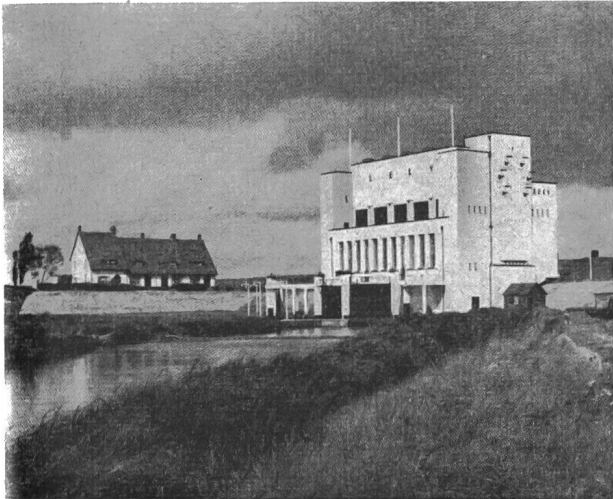
Fig. 9 L'impianto di pompaggio «Lely»
