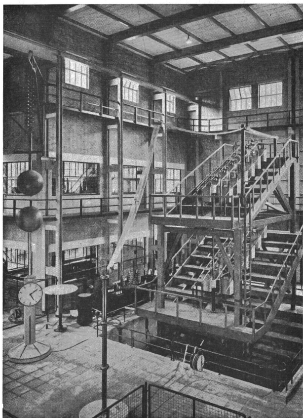
Fig. 5 Laboratorio prove ad alta tensione
