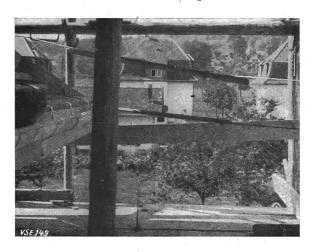
Fig. 5 Accident mortel en basse tension sur un échafaudage traversé par une ligne insuffisamment protégée Un couvreur à trouvé la mort ici. Tension en jeu: 250 V
