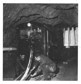
Fig. 19 Verlegung der 150-kV-ölkabel mit Stollenlokomotive
