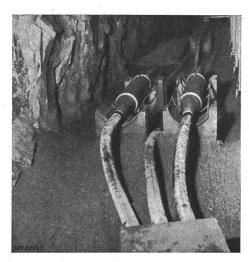
Fig. 20 Kabelstollen Grimsel-Gerstenegg Muffenverbindung der 150-kV-ölkabel
