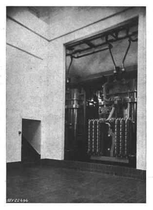
Fig. 14 Teilansicht der Dreiphasen-Transformatorengruppe mit Kühlaggregat im Maschinenhaus Grimsel
